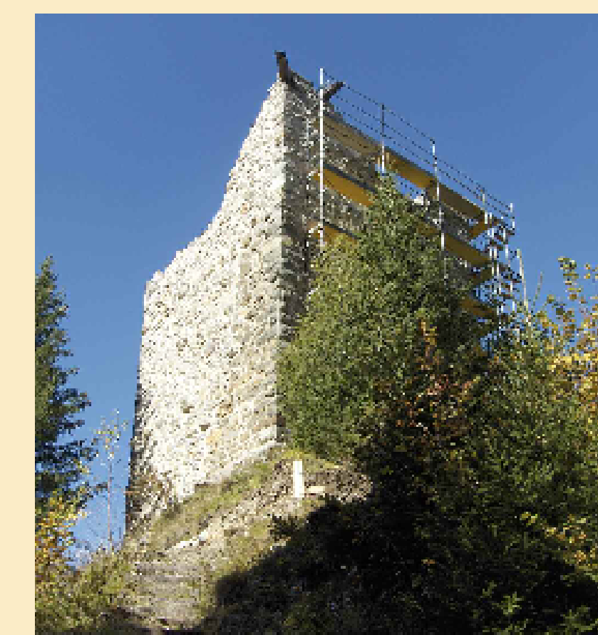
2007: Die Südfront ist gesichert, zwei neue Lärchenstümpfe lokalisieren die verfallenen Kragbalken der Wehrlaube.
