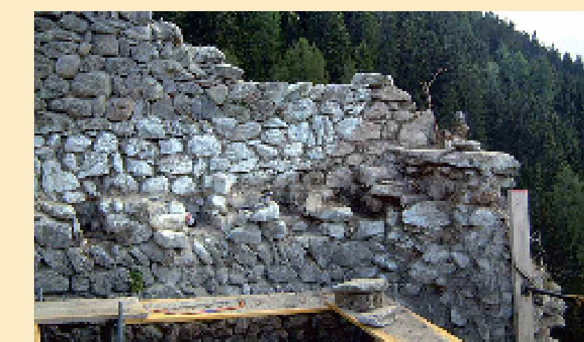
Vorzustand 2004: Balkenlage des dritten Geschosses. Rechts die Torschwelle des Hocheinganges, gut acht Meter über Boden.
